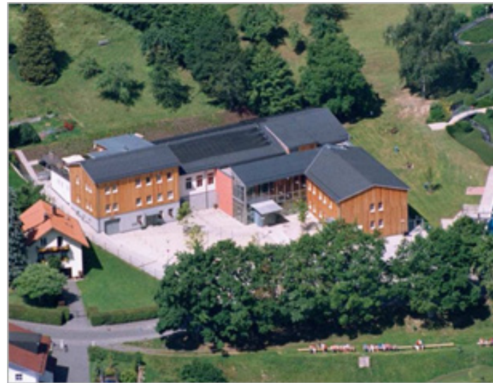
Herrnböck-Fabrik nach dem Umbau
