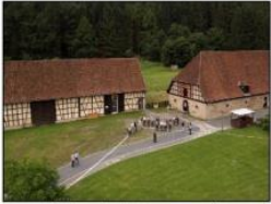
Depot für das Gerätemuseum Ahorn (Quelle: Eigene Aufnahme)
