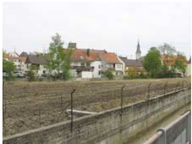
Ilm-Insel Pfaffenhofen in saniertem Zustand
