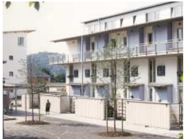
Paschendeale-Kaserne, Neubau im Baugebiet 1
