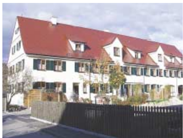
Umnutzung einer Hofstelle zu mehreren Wohneinheiten - Seitenansicht der ehemaligen Hofstelle mit vier Wohneinheiten
