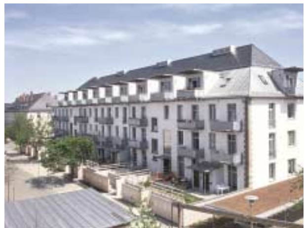
Paschendeale-Kaserne, saniertes Gebäude im Baugebiet 1
