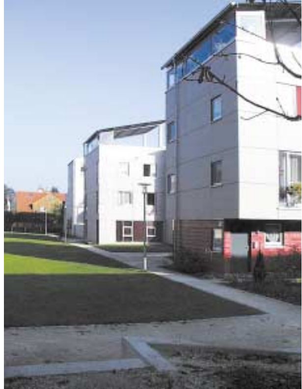
Kopfbauten der Neubauten B, C und D im bisher ungenutzten Hofbereich
