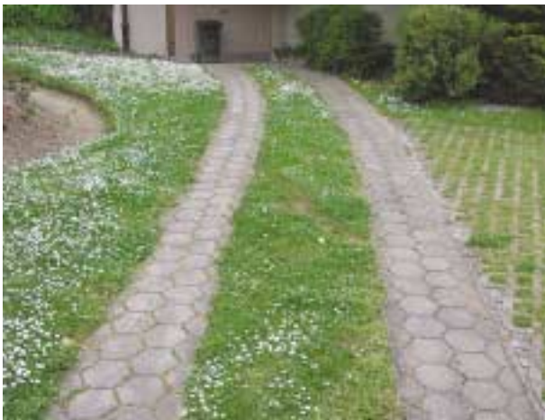
Versiegelungsarme Zufahrt auf Privatgrundstück in Pfaffenhofen a. d. Ilm
