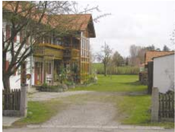
Umgenutzte Hofstelle für Wohnen in Jengen
