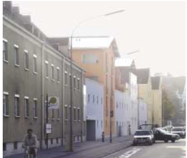
Schallschutzbebauung entlang der Regensburger Strasse
