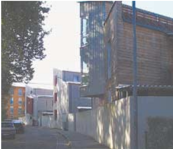
Gerhart-Hauptmann-Strasse von Osten: Nachverdichtung durch Neubauten
