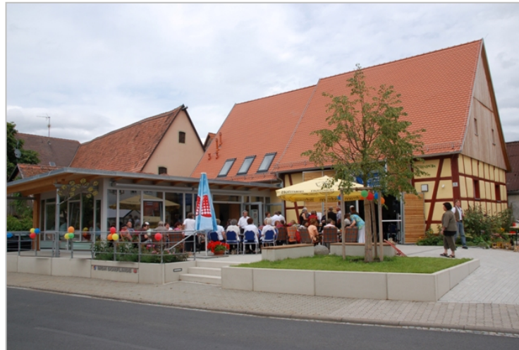
MehrGenerationenHaus (MGH) - Dorflinde
