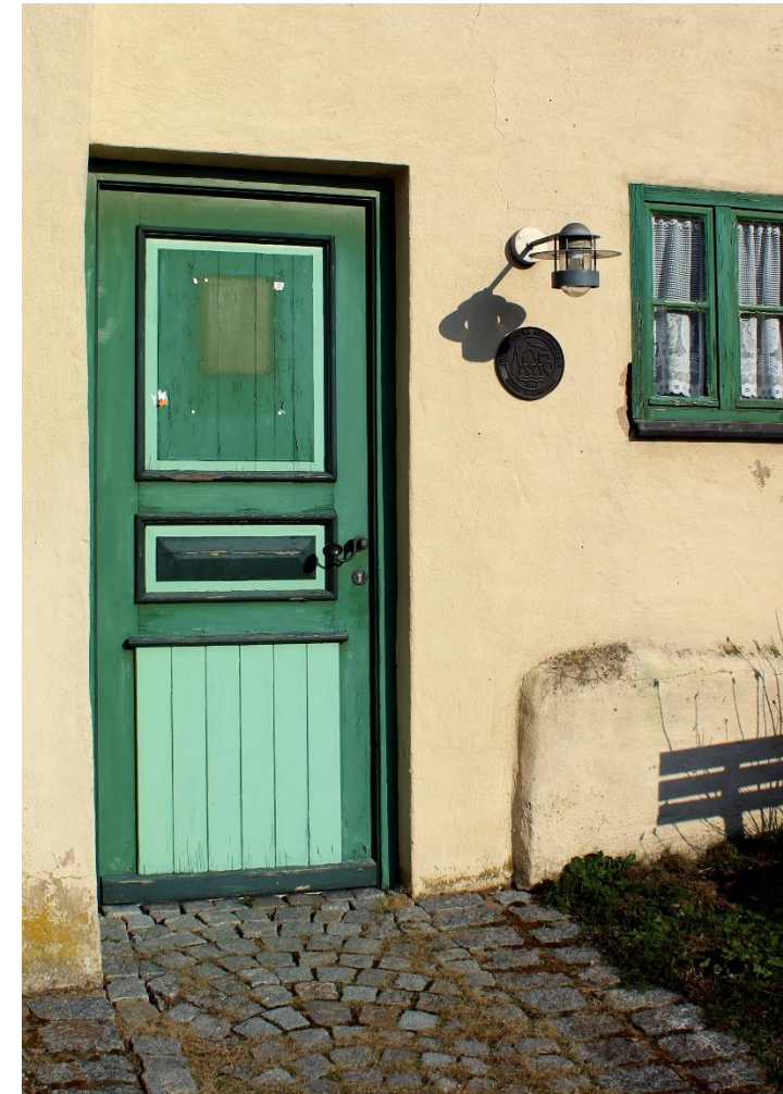
Eine sanierte Hausfassade in der Region Hesselberg
