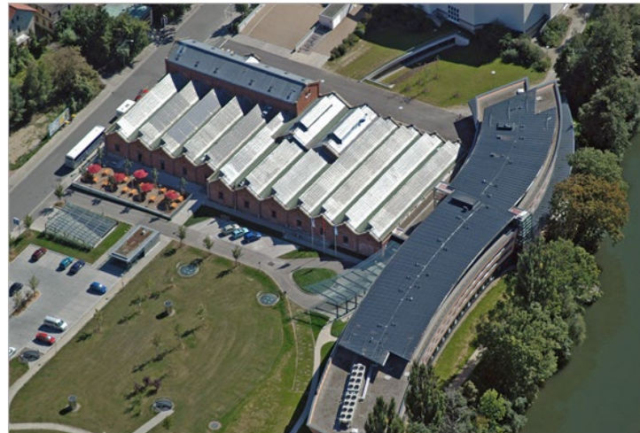
Sanierter Ziegelbau und Neubau Hotel im Luftbild
