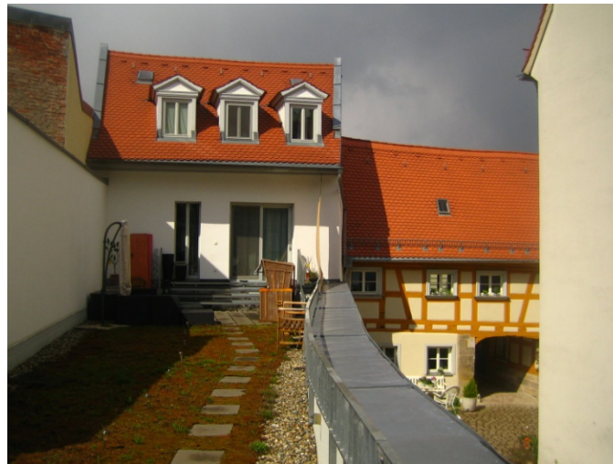
Sanierung denkmalgeschützter Bausubstanz
