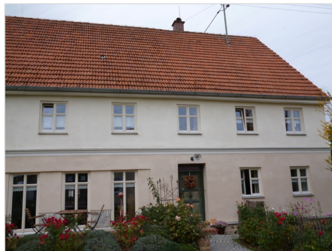
Umbau und Sanierung eines ehem. landwirtschaftlichen Anwesens in ein Wohnhaus in Langenhaslach
