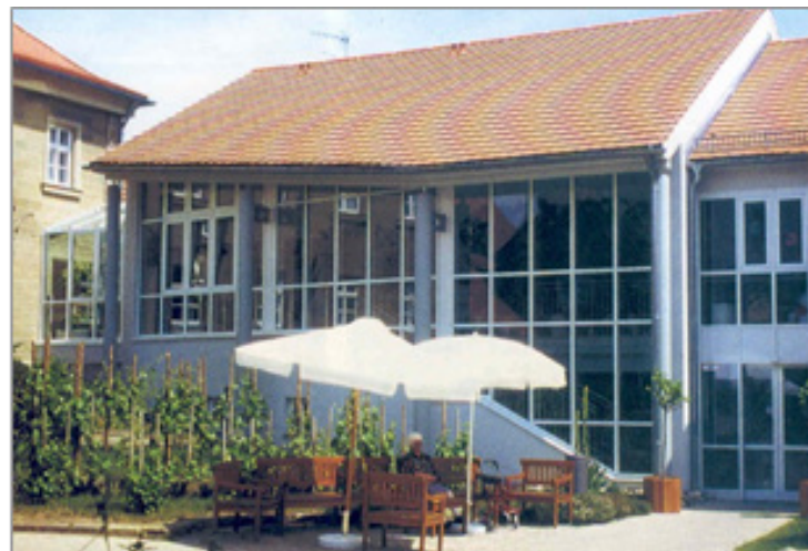
Neu gebautes Altenbetreuungszentrum im Ortskern
