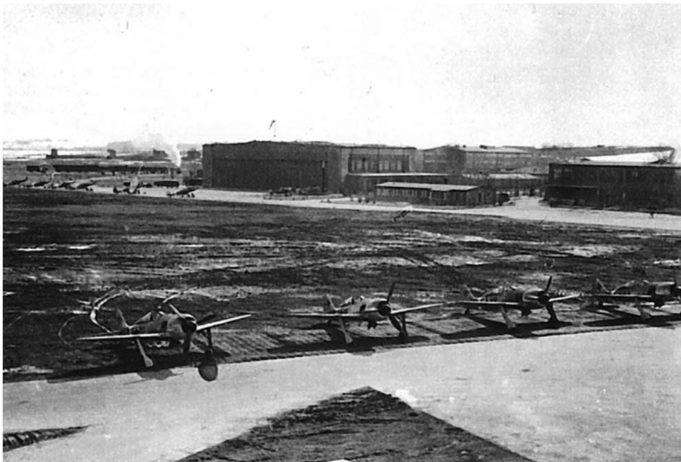
Abb. 2: Flugplatz Erding, Nerdinger, 1993
