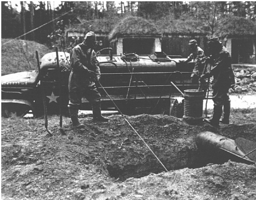
Abb. 8: Luft-Munitionsanstalt 2/VII Schierling (W8306.00) Neutralisation der Kampfstofffüllung einer Tabun-Bombe, 17. Mai 1946, National Archives, Washington
