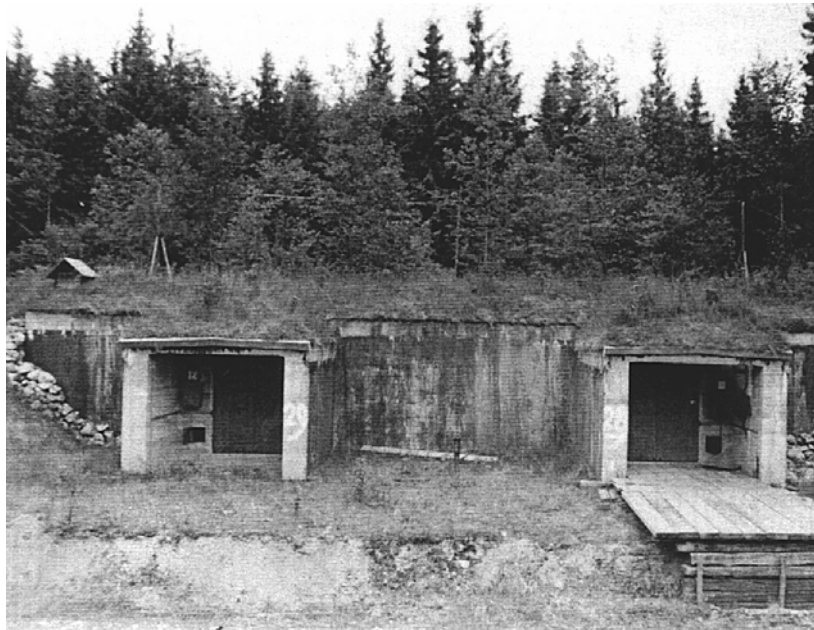
Abb. 4: Luft-Munitionsanstalt 2/VII Schierling (W8306.00), Bunker für Senfgasbomben, 17.Mai 1946, National Archives, Washington
