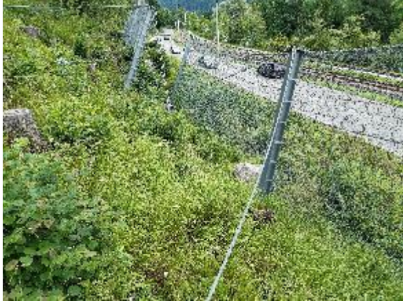
Abb. 25: Ein neu errichteter Steinschlagschutzzaun schützt die Verkehrsteilnehmer auf der Bundesstraße 2, nördlich von Oberau vor Felsblöcken aus dem etwa 150 m hohen Hang. © Franziska Weinzierl, Zentralstelle Ingenieurbauwerke und Georisiken (ZIG), München
