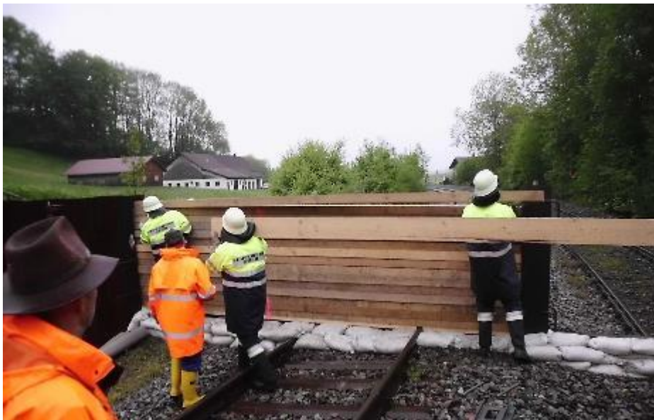
Abb. 24: Bislang wird ab einem bestimmten Wasserstand der Iller in Immenstadt eine mobile Hochwassersperre aufgebaut. Da sie über die Bahnstrecke Kempten – Immenstadt verläuft, muss der Zugverkehr dann eingestellt werden. © Stadt Immenstadt
