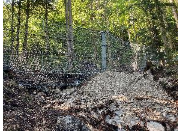
Abb. 26: Eine neu errichtete Seilsperre oberhalb der Staatsstraße 2089, nördlich von Oberaudorf schützt den Straßenverkehrsteilnehmer vor Muren, die im Zusammenhang mit Stark- und Dauerniederschlagsereignissen aktiv werden. © Andreas Koch, Zentralstelle Ingenieurbauwerke und Georisiken (ZIG), München
