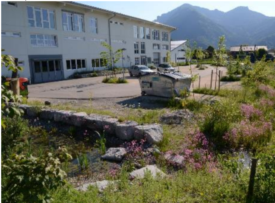
Abb. 27: Der Parkplatz von Skywalk mit Regenwasser-Versickerungsmulden am Rand des Geländes. Nur die stark frequentierte Durchfahrt wurde asphaltiert. © www.reinhard-witt.de
