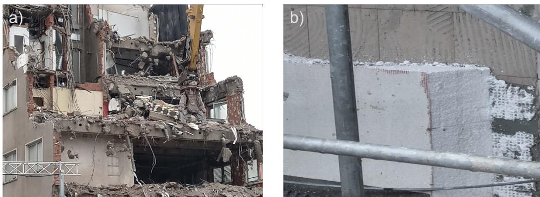
**Abbildung 2.1:** Abbruch eines Wohnhauses im Großraum Nürnberg (a) und händischer Abriss der WDVS von der Gebäudefassade (b)
