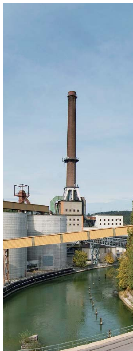
Heizkraftwerk einer Papierfabrik Foto: UPM-Kymmene Papier GmbH & Co. KG
