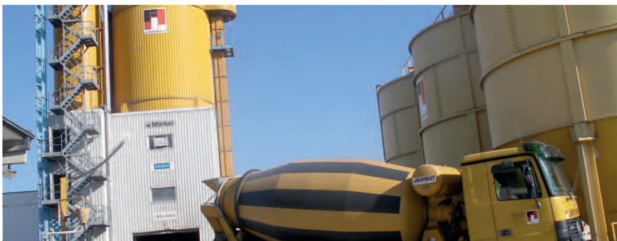
Foto: Transportbetonturm mit Kiessilos auf dem Firmengelände der Fa. Lindermayr, Derching
