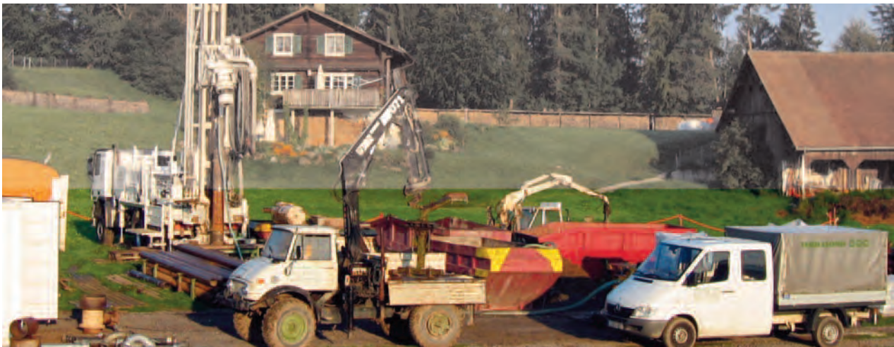
Foto: Brunnenbohrung, Schindellegi-Schweiz
